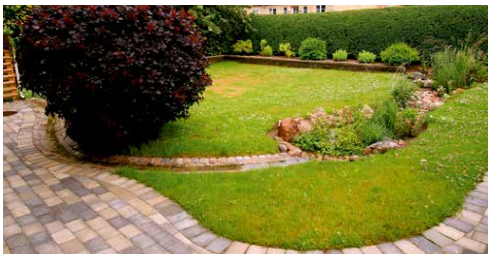
Stenlagd regnvattenränn som leder regnvatten från terrassen till regnbädden på husets framsida.
