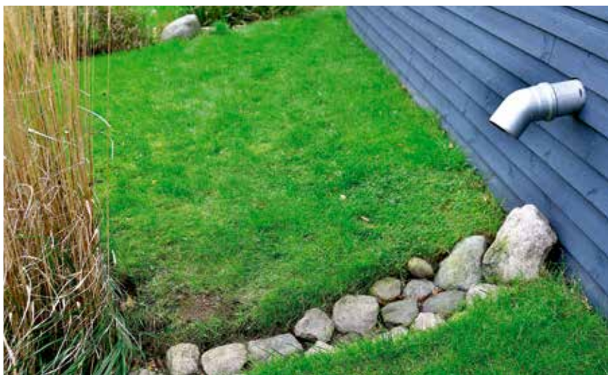
Regnvatten i fritt fall från terrassen till regnbädden på husets framsida.
