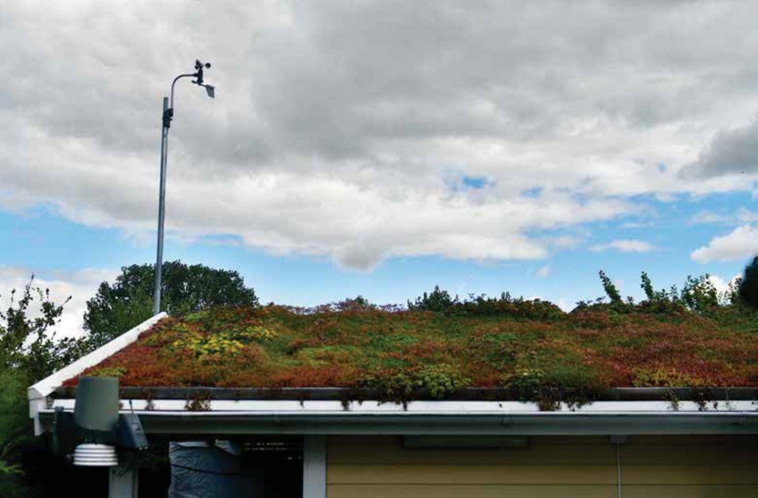
Trädgårdsboden har försetts med ett sedumtak som tar tillvara mycket av det regnvatten som hamnar på taket.
